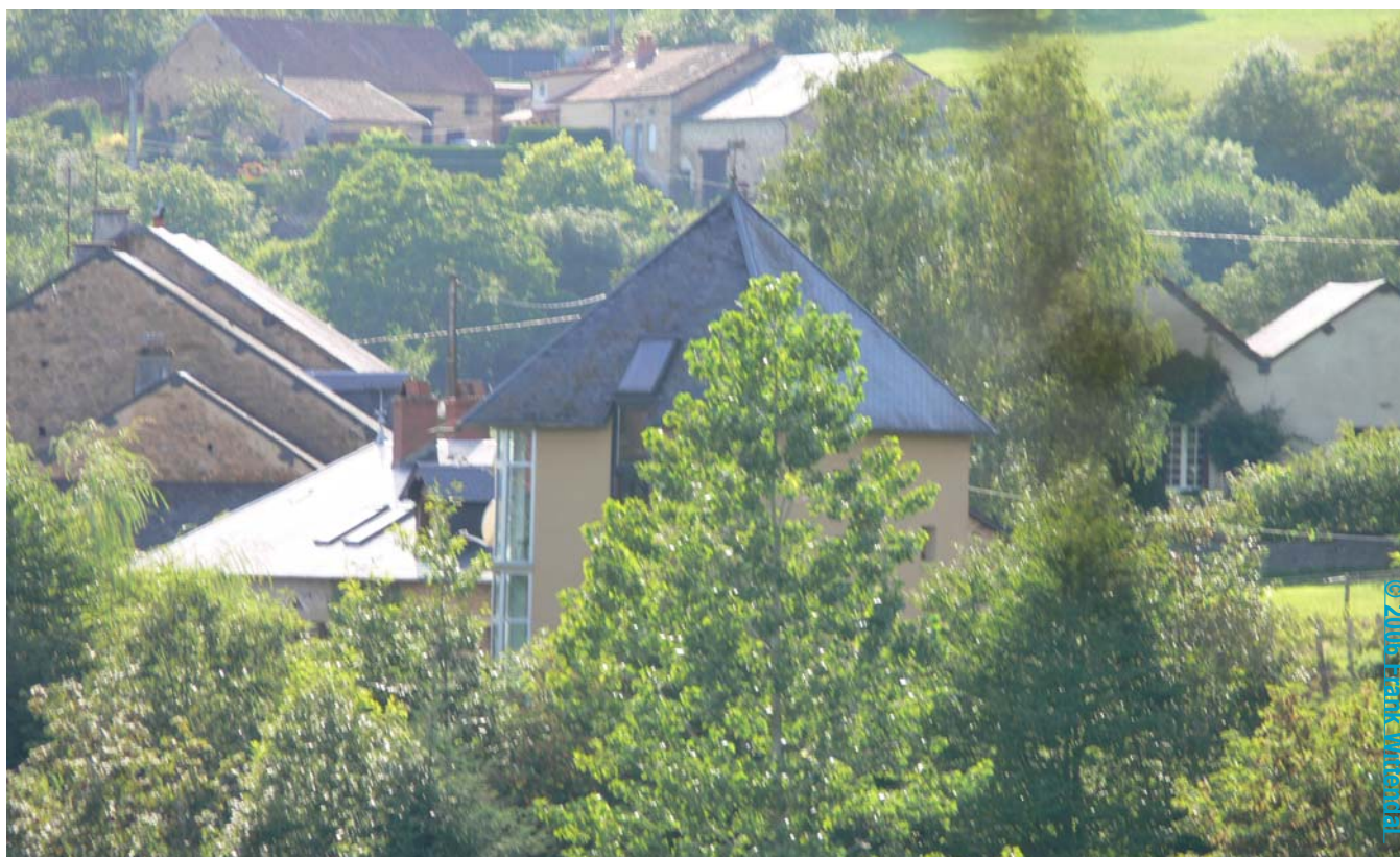
Photo n°2 : Les maisons du Morvan – Qui n'est pas conforme ?
